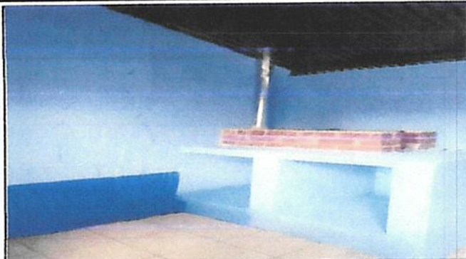
Foto 2: Instalacion de estufa y polleton en cocina
