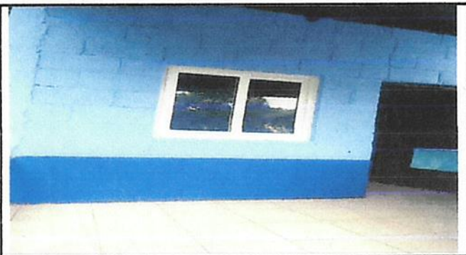
Foto 5: colocacion de piso en cocina
