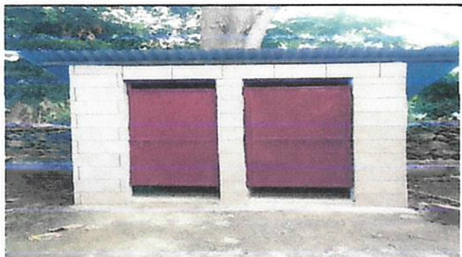
Foto 3: Instalacion de puertas de baños
