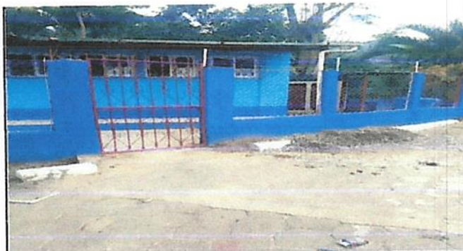
Foto 6: Pintura en muros interiores y exteriores
