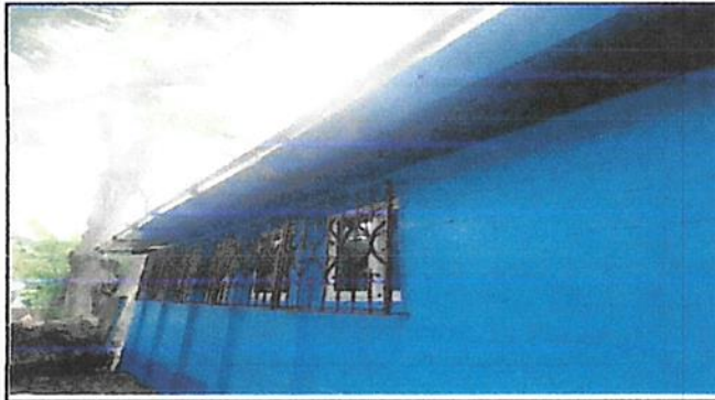
Foto 2: Instalacion de canales y bajadas de agua
