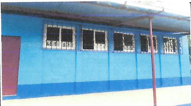
Foto 3: Instalacion de piso en el aula
