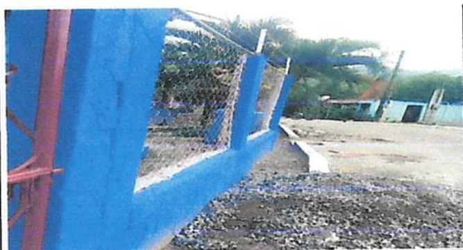
Foto 5: Reparacion de malla y muro perimetral
